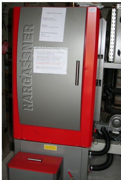
Face avant de la chaudière avec le cendrier amovible au 1 er plan en bas
