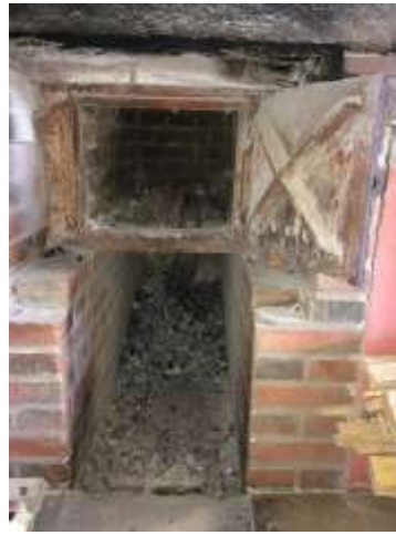
En haut le foyer pour les flammes et en bas le cendrier pour les cendres
