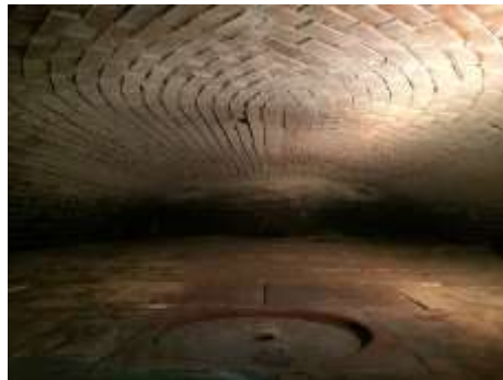
Une voûte en brique et une sole en brique réfractaire de 9m 2 . Il faut plus de 2h pour mettre le four à température de 260/280°
