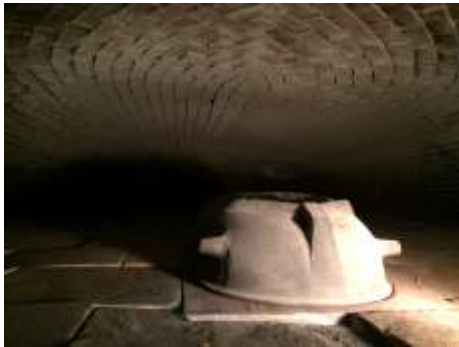
Du foyer les flammes sortent /gueulent dans une pièce en fonte qui s'appelle le « gueulard »
