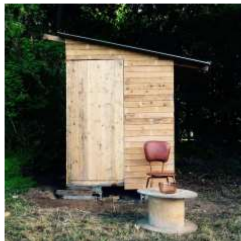
Arrivée d'un toilette sèche démontable en juin 2017
