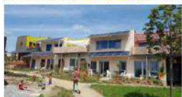
10 logements à Forcalquier (04)
