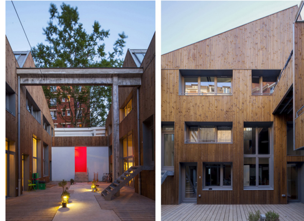
MELROSE SHEDS : restructuration d'un entrepôt des années 1950, pour 10 logements et un local professionnel à Pantin (93) Projet en autopromotion d'habitat groupé.
